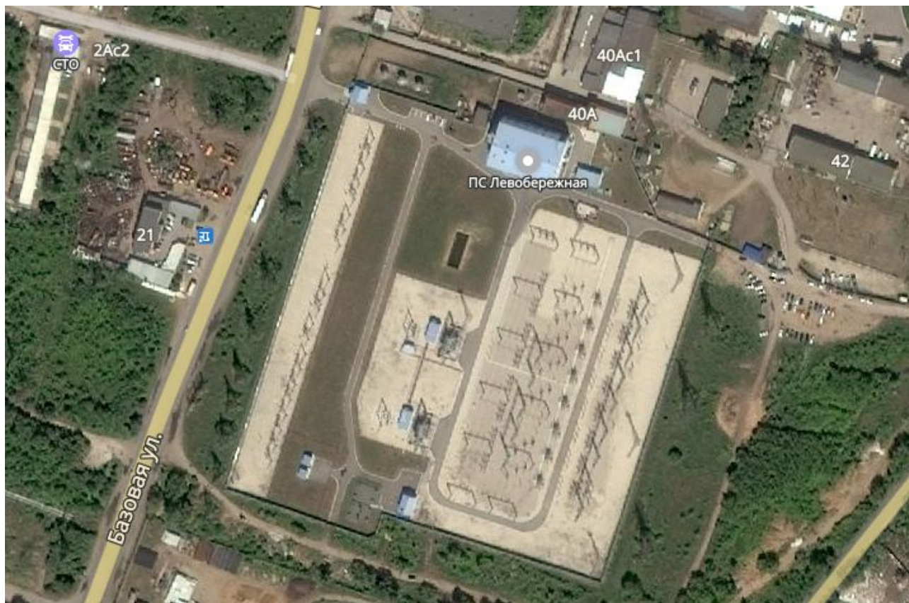
Рисунок 1.1. – Подстанции 220/110/10 кВ «Левобережная» на территории Центрального района города Тольятти
