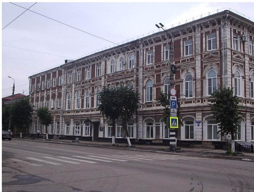
Рисунок 1.1 - Внешний вид фасада здания
