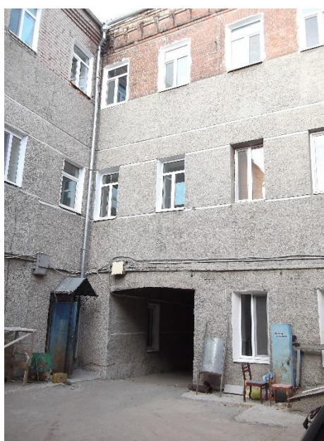
Рисунок 2.2 - Вид здания поликлиники со двора
