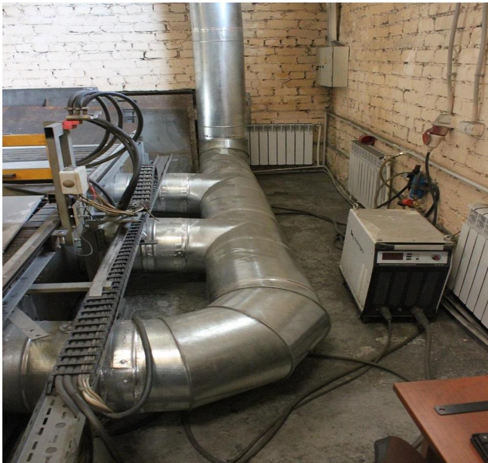
Рисунок 3.28 – Вытяжная системы плазменного стола
