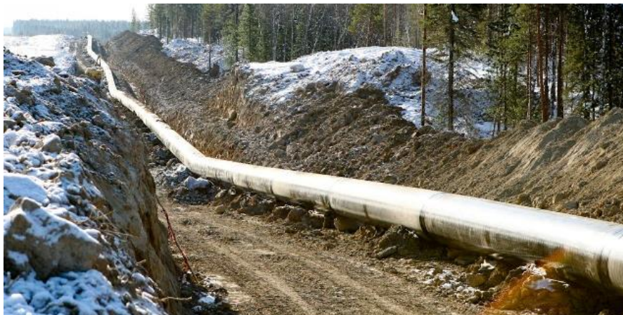
Рисунок 1.2 – Промысловый нефтепровод диаметром 1020 мм
