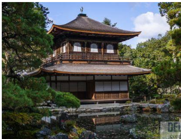
Рисунок 6 - двускатная тростниковая кровля
