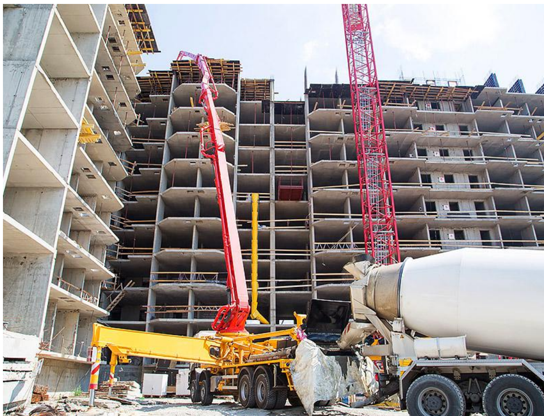
Рис.3.5. подача бетона с автобетононасосом
