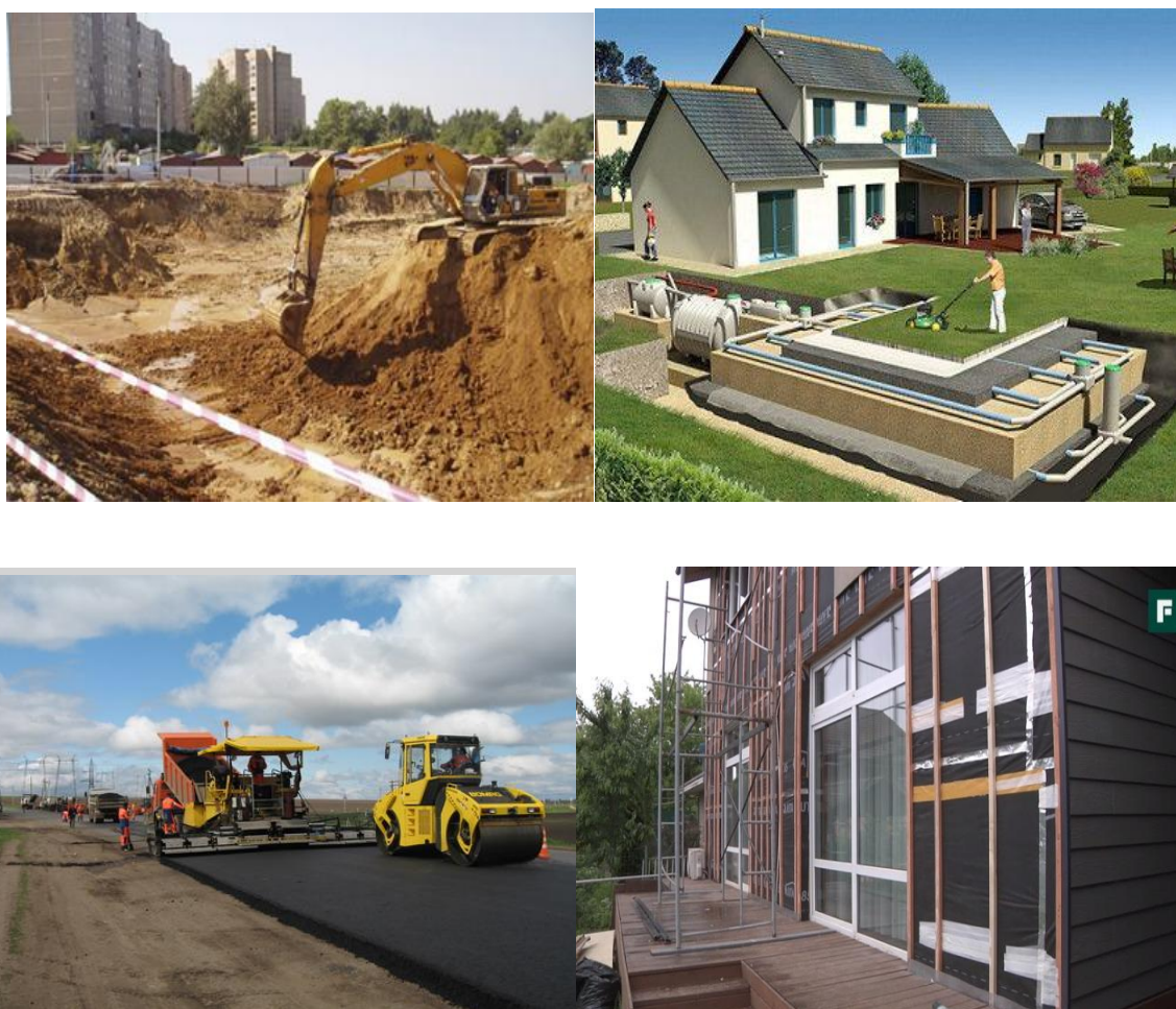
Рисунок 2.7 - Примеры строительных работ
