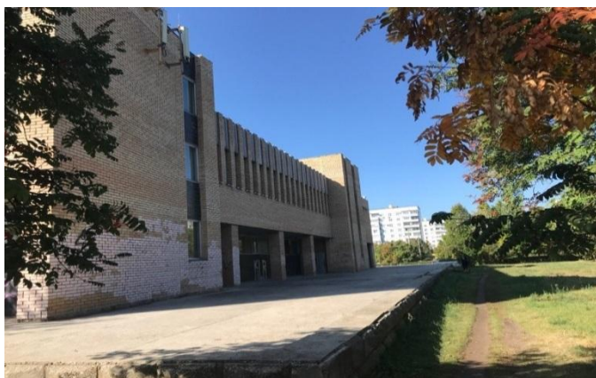
Рисунки 3.7 - 3.24 - Фото фиксация здания и территории музыкальной ШКОЛЫ
