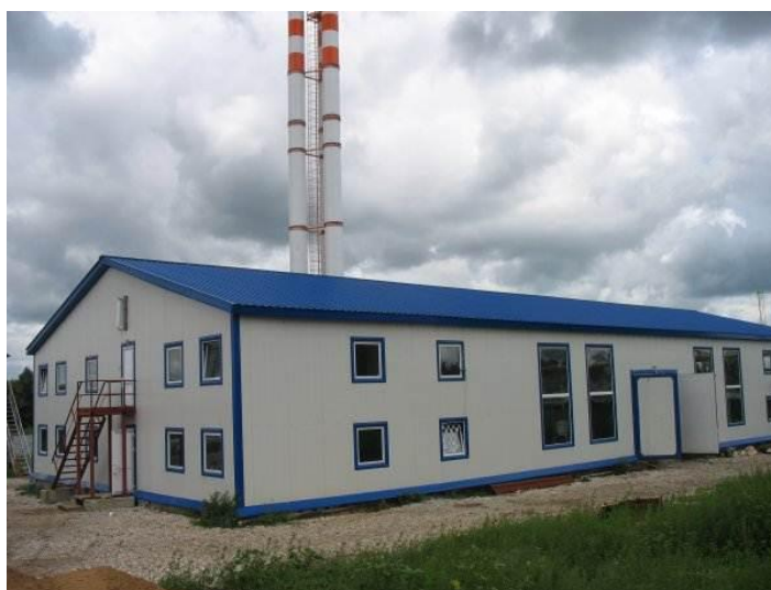
Рисунок 2.1 – Вид котельной пос. Поволжский
