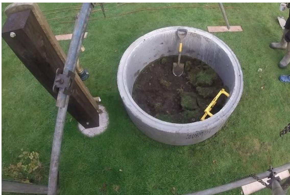
Рисунок 1.23 – разработка грунта внутри бетонного кольца
