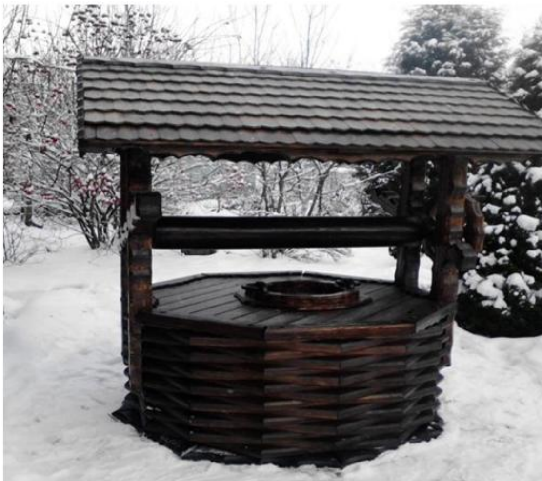
Рисунок 1.7 – Отделка оголовка колодца деревом
