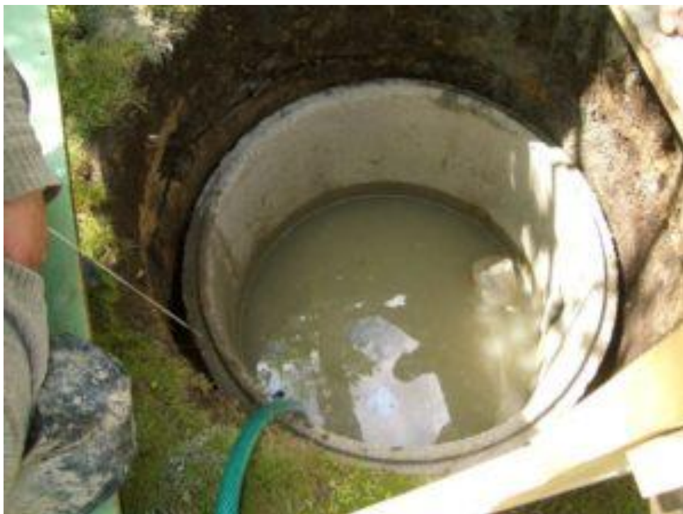
Рисунок 1.19 – Откачка воды из колодца
