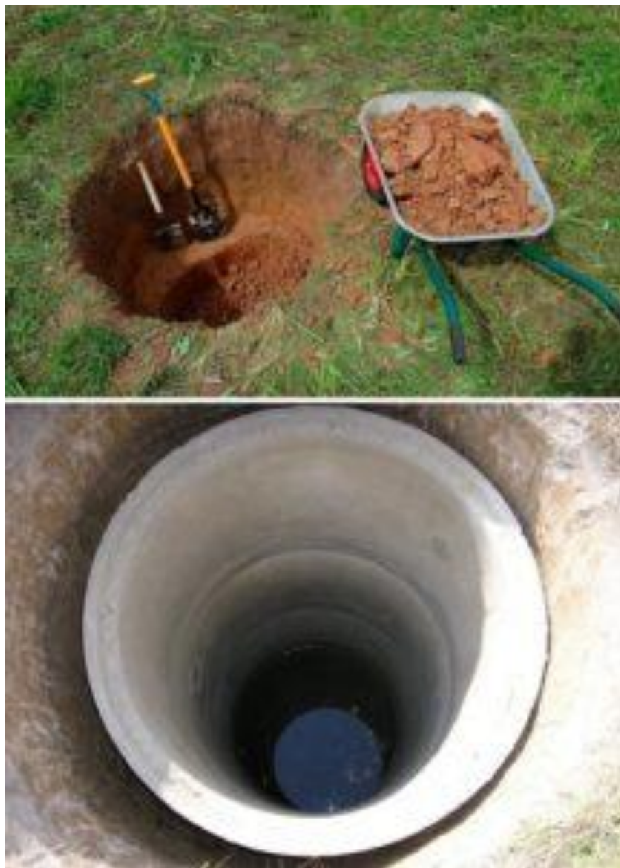
Рисунок 1.17 – Строительство шахтного колодца
