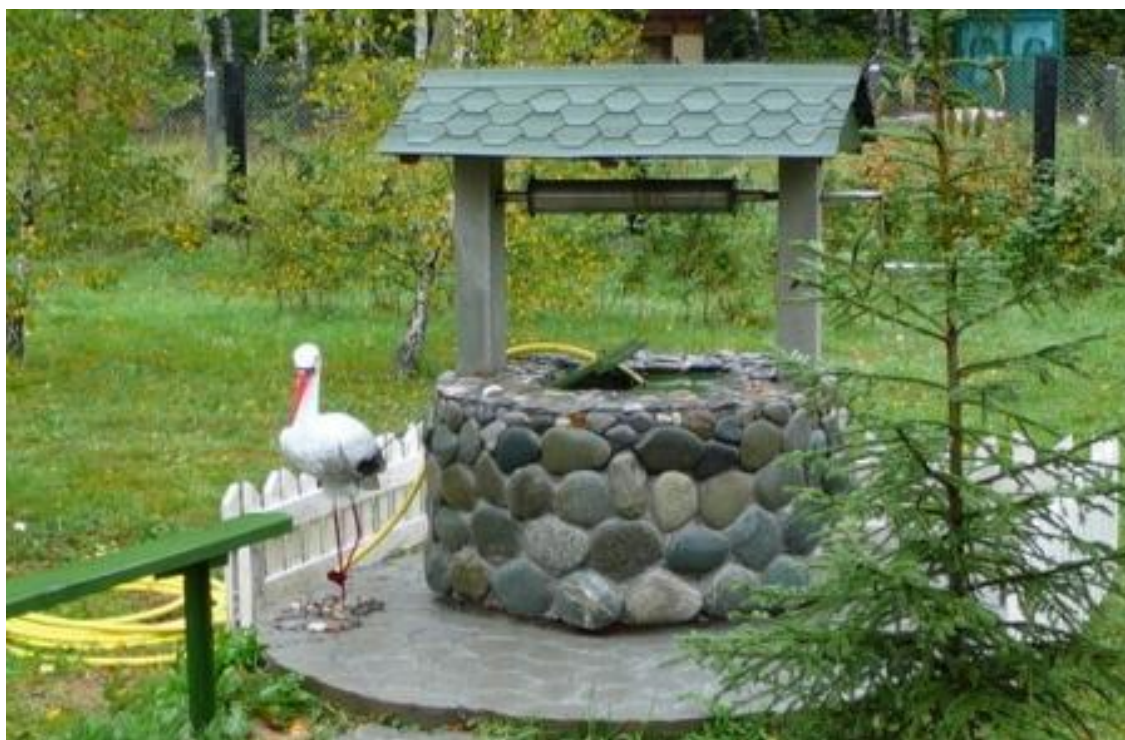
Рисунок 1.6 – Отделка оголовка колодца камнем
