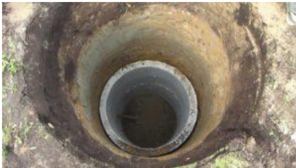
Рисунок 1.15 – Строительство шахтного колодца
