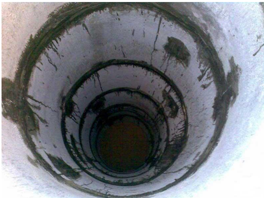
Рисунок 1.9 – Шахта колодца из бетонных колец
