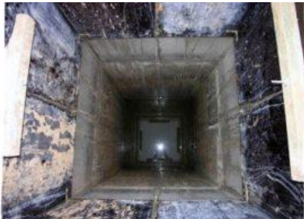
Рисунок 1.16 – котлован под колодец
