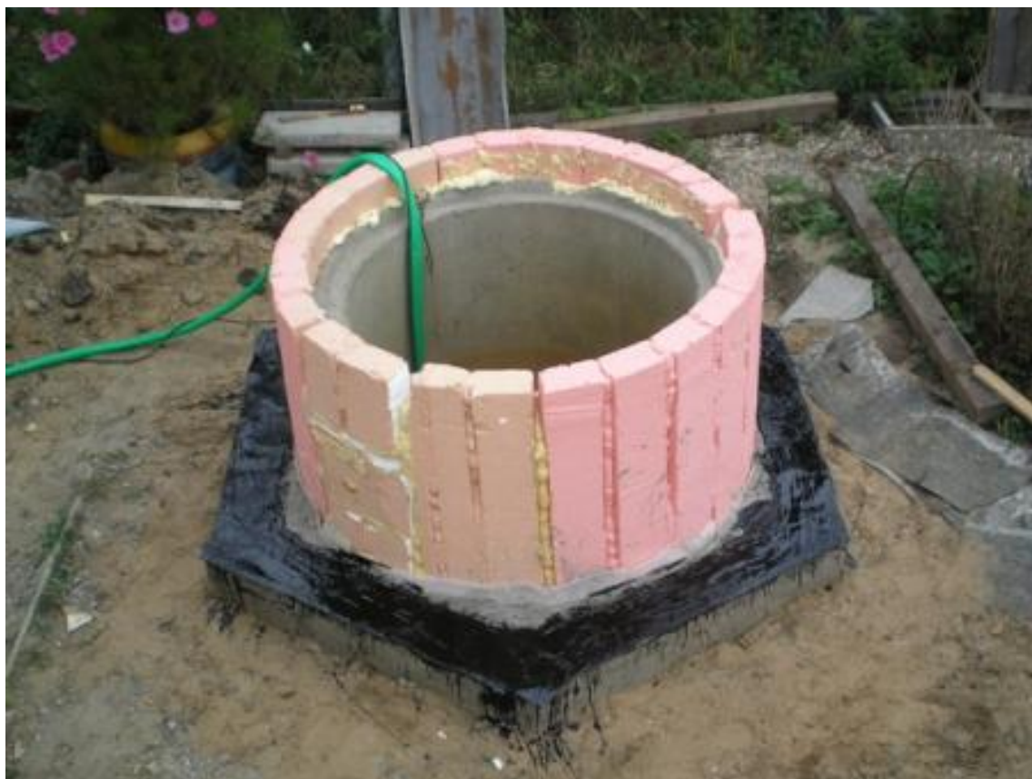
Рисунок 1.8 – Утепление оголовка колодца
