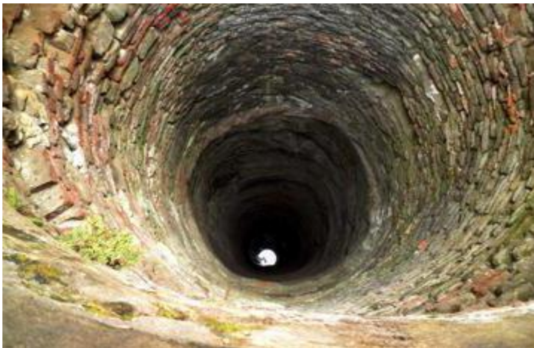
Рисунок 1.10 – Шахта колодца с облицовкой из кирпича
