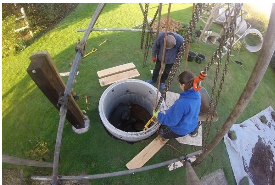
Рисунок 1.24 – Опуск бетонного кольца
