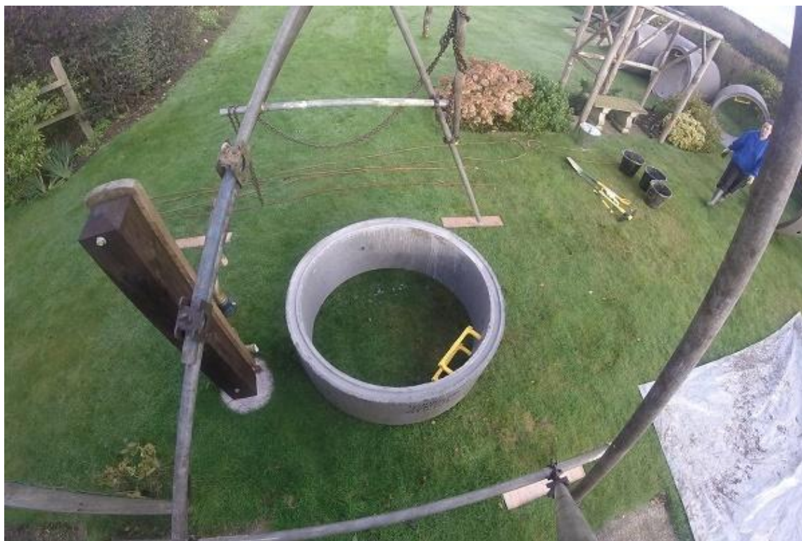
Рисунок 1.22 – установка бетонного кольца
