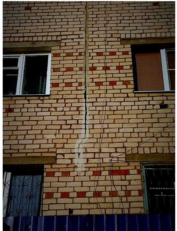
Рисунок 3 – Образование трещины ниже деформационного шва, выполненного только в верхней части жилого дома (г.Тольятти, ул. Жилина, дом 54)
