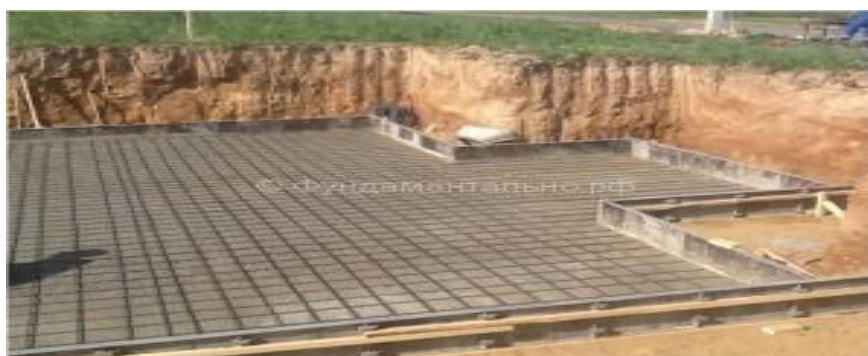
Рисунок 3.3 – Установка опалубки
