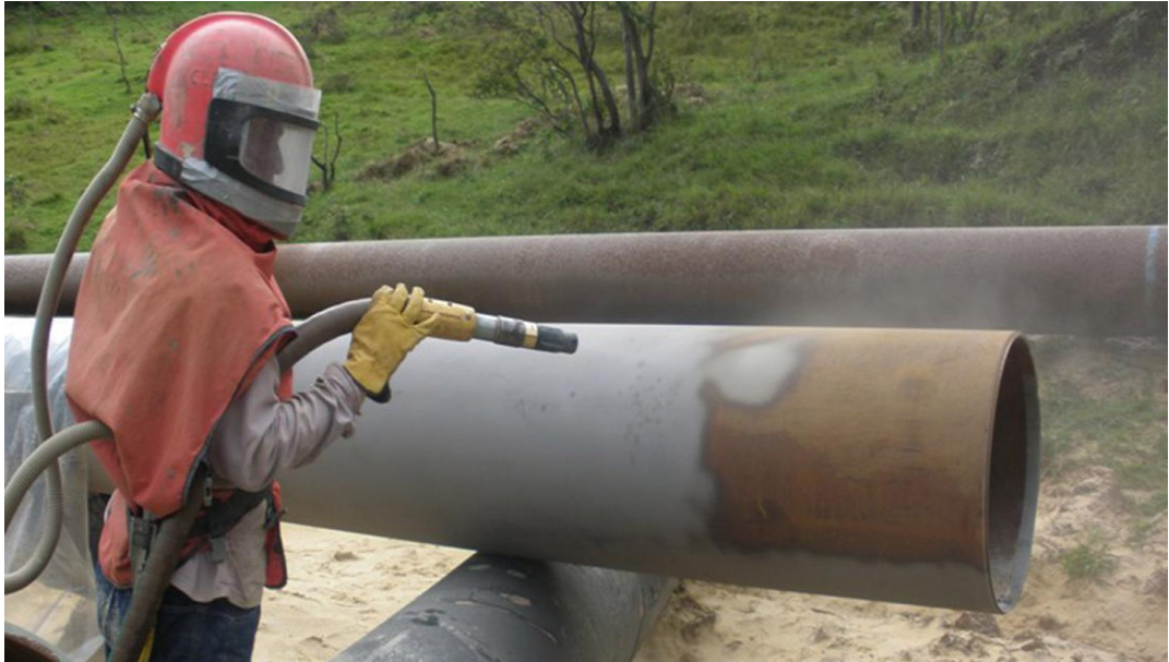
Рисунок 10 - Абразивоструйная очистка – способ очистки поверхности металла от коррозии
