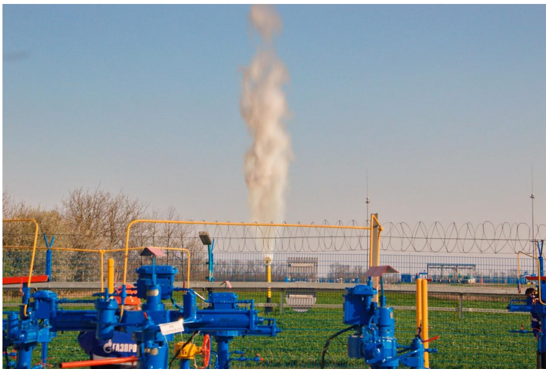
Рисунок 2 - Продувка газопровода
