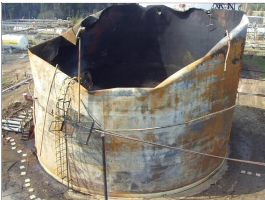
Рисунок 3 - Резервуар № 2. Вид с восточной стороны
