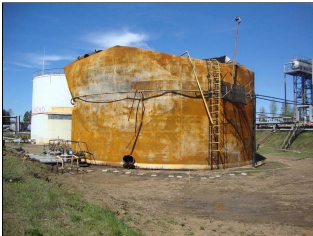
Рисунок 2 - Резервуары № 2 и № 3 с юго-восточной стороны
