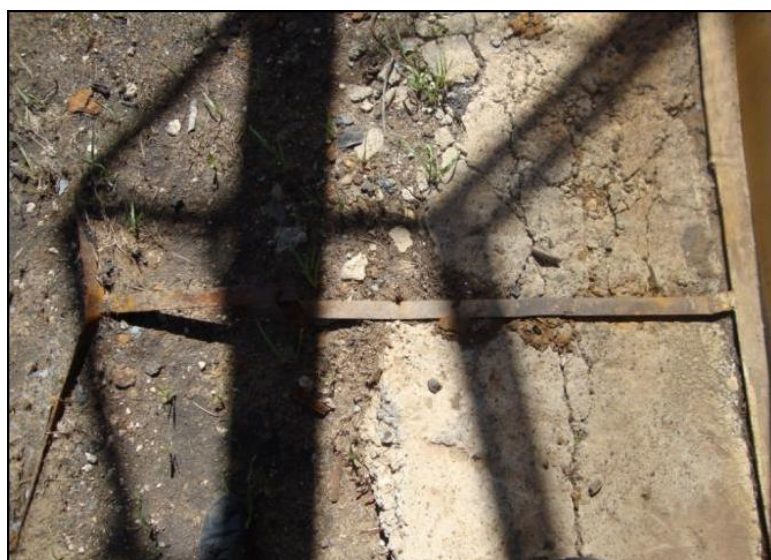
Рисунок 6 - Элемент заземления, расположенный с восточной стороны резервуара
