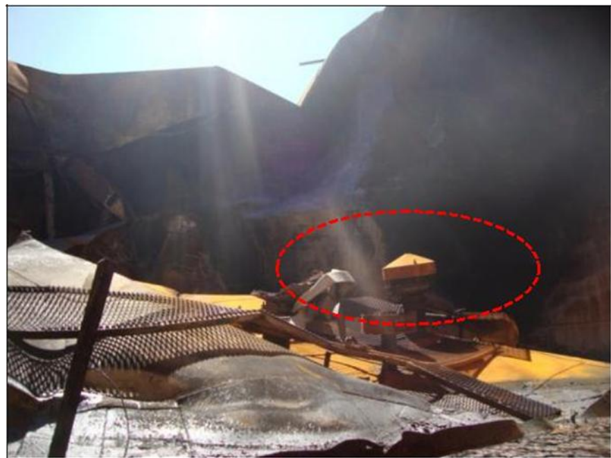
Рисунок 10 - Участок внутренней поверхности юго-западной стенки резервуара. Прерывистой линией выделено два дыхательных клапана резервуара
