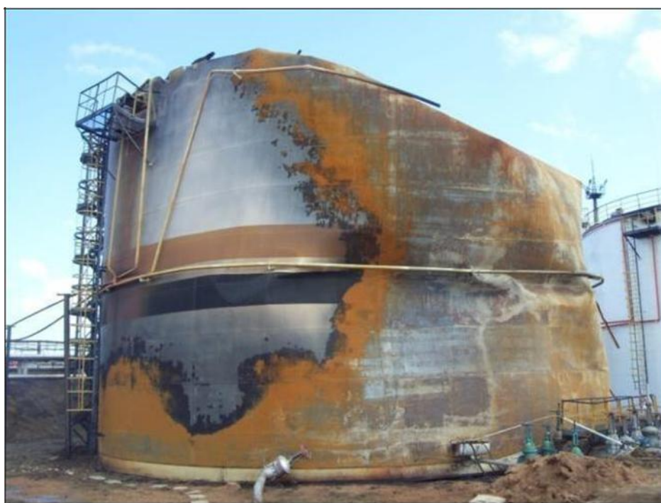
Рисунок 4 - Резервуар № 2. Вид с юго-западной стороны
