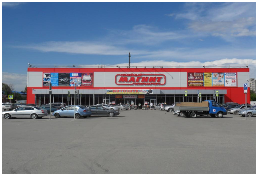
Рисунок 1.1 – Центральный вход Универсам «Магнит»
