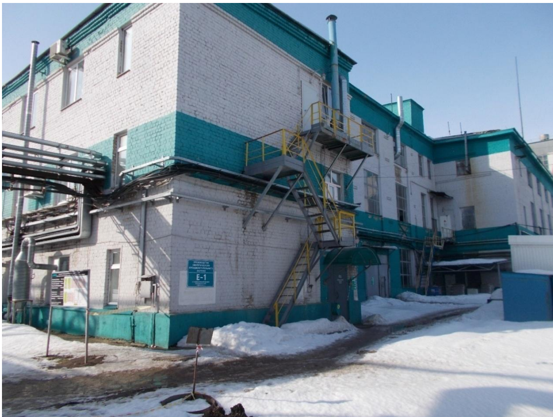
Рисунок Б.1 – Фото объекта с северной стороны здания
