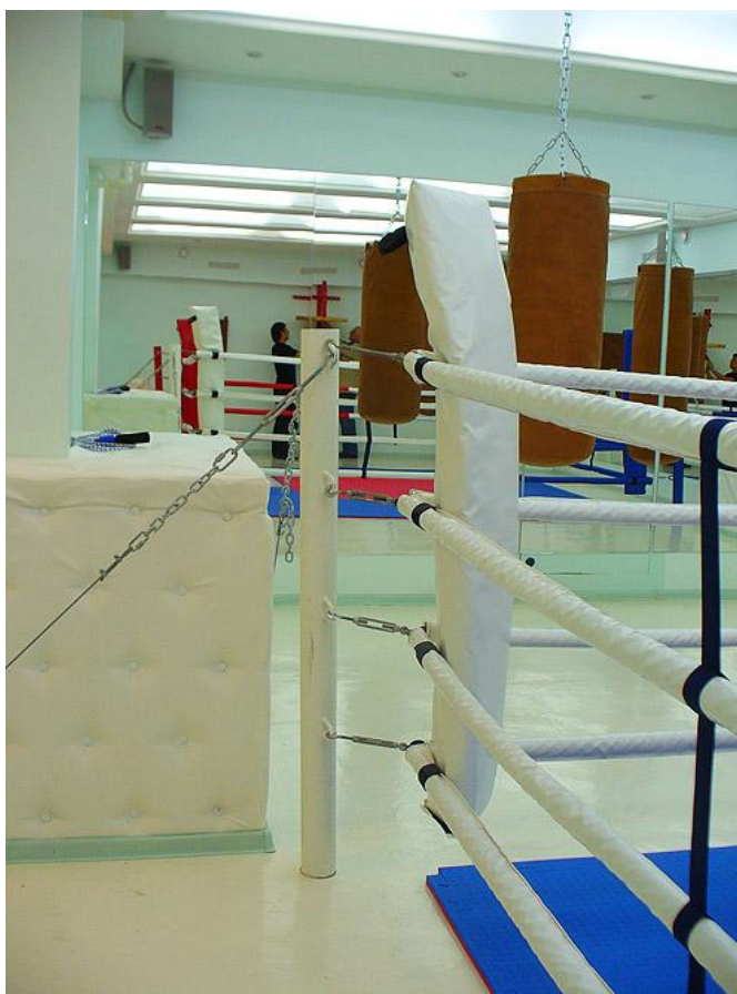
Рисунок 1.4 - Крепление узла стоек боксерского ринга с помощью вант
