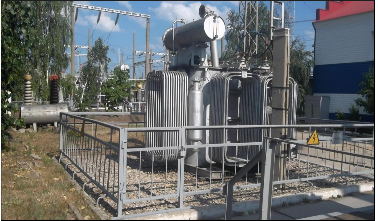
Рисунок 2.1 – Внешний вид трансформатора типа УТМРУ–6300/6
