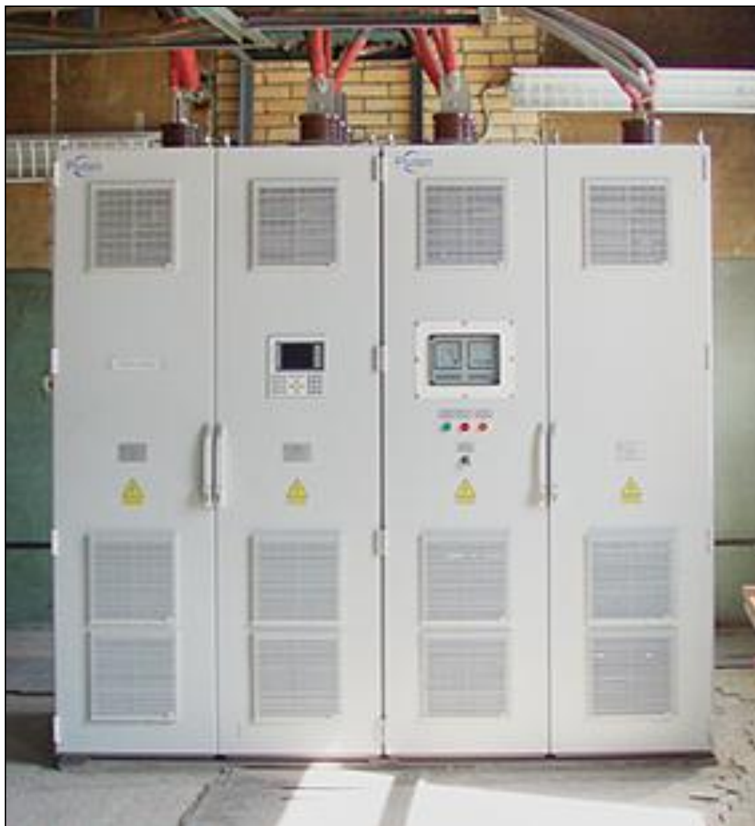
Рисунок 3.3 - Преобразовательная секция выпрямителя ТПЕД–3150–3,3к–У1
