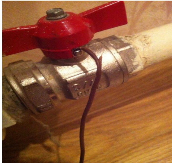
Фото 3.1 Подключение заземления
