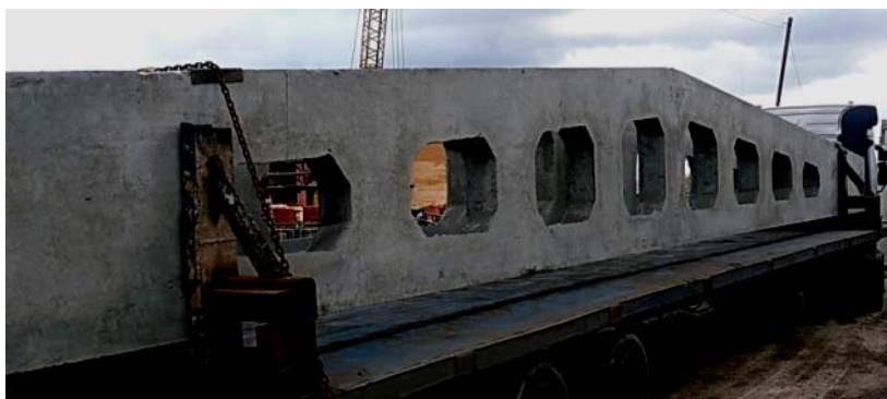
Рис. 3.10. Двускатная стропильная балка
