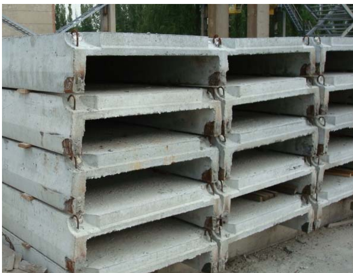
Рис. 3.6. Фото плит покрытия
