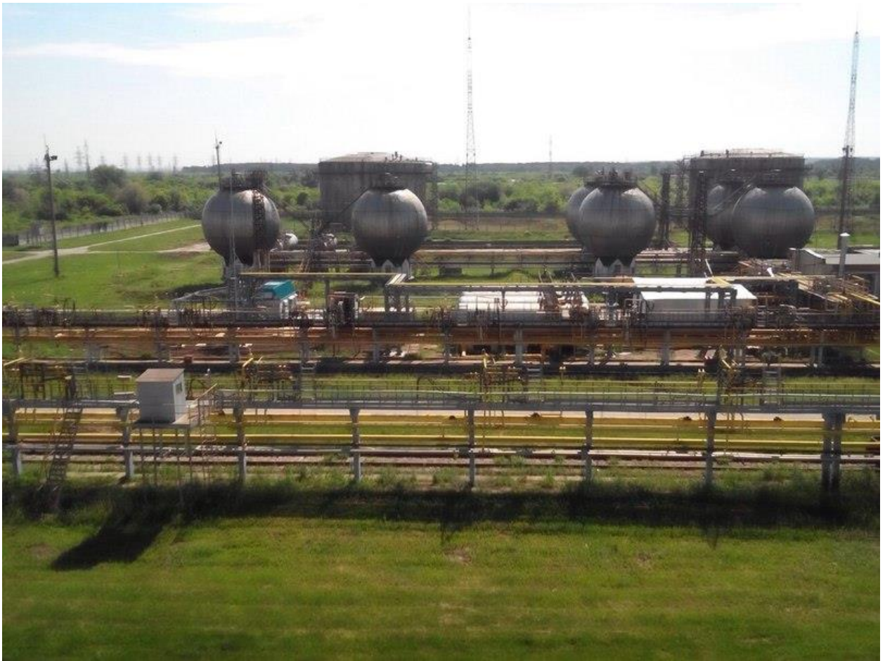
Рисунок 1 – Сливно-наливные эстакады
