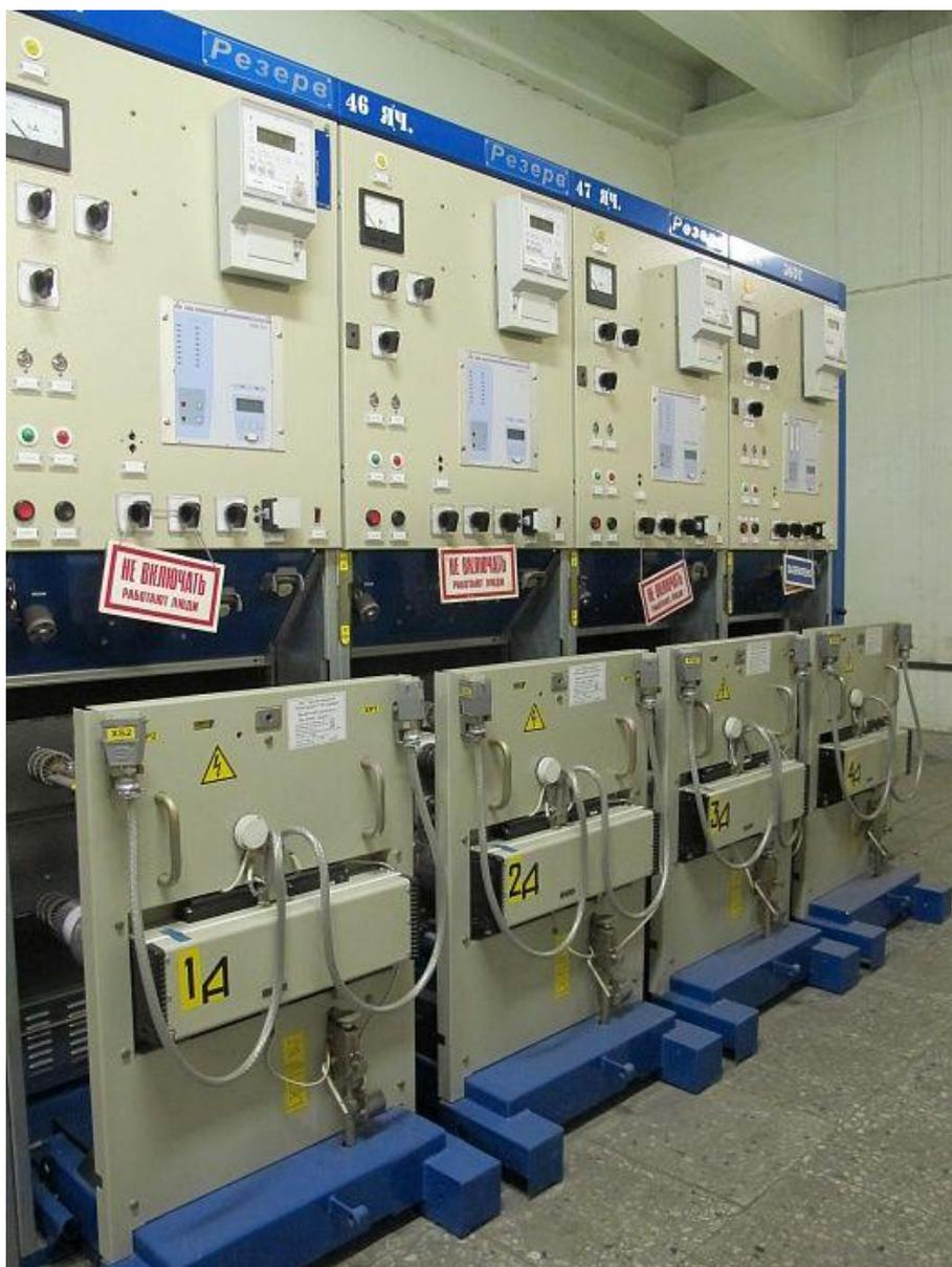
Рисунок 7.2 – Пример установки ячеек КРУ серии СЭЩ-63 на в ЗРУ 6 кВ
