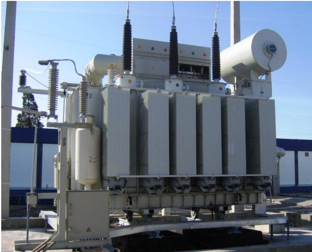
Рисунок 9 – Трансформатор ТРДН-25000/110/10/10
