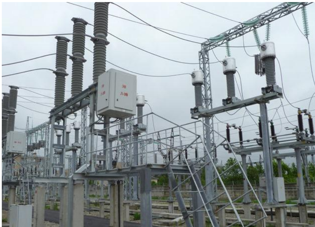
Рисунок 3 – ОРУ-110 кВ после реконструкции
