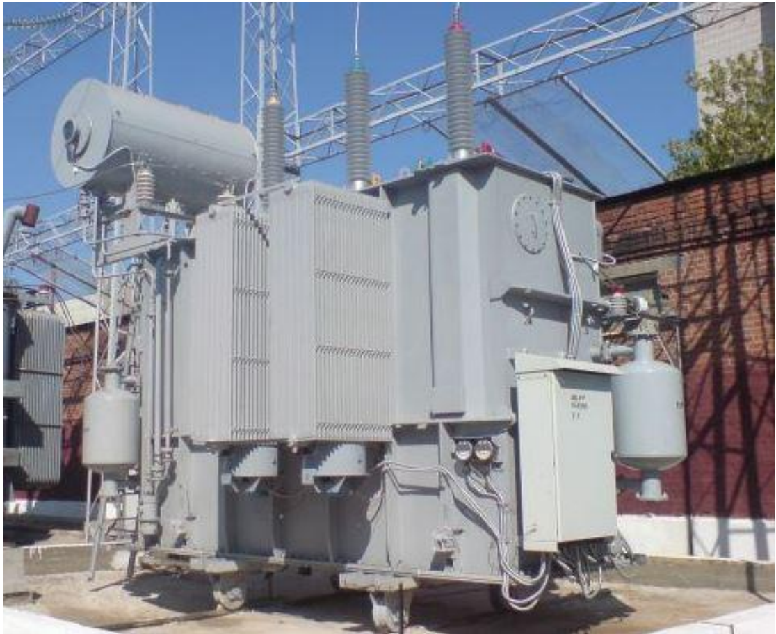
Рисунок 8 – Трансформатор ТРДН-16000/110/10/10
