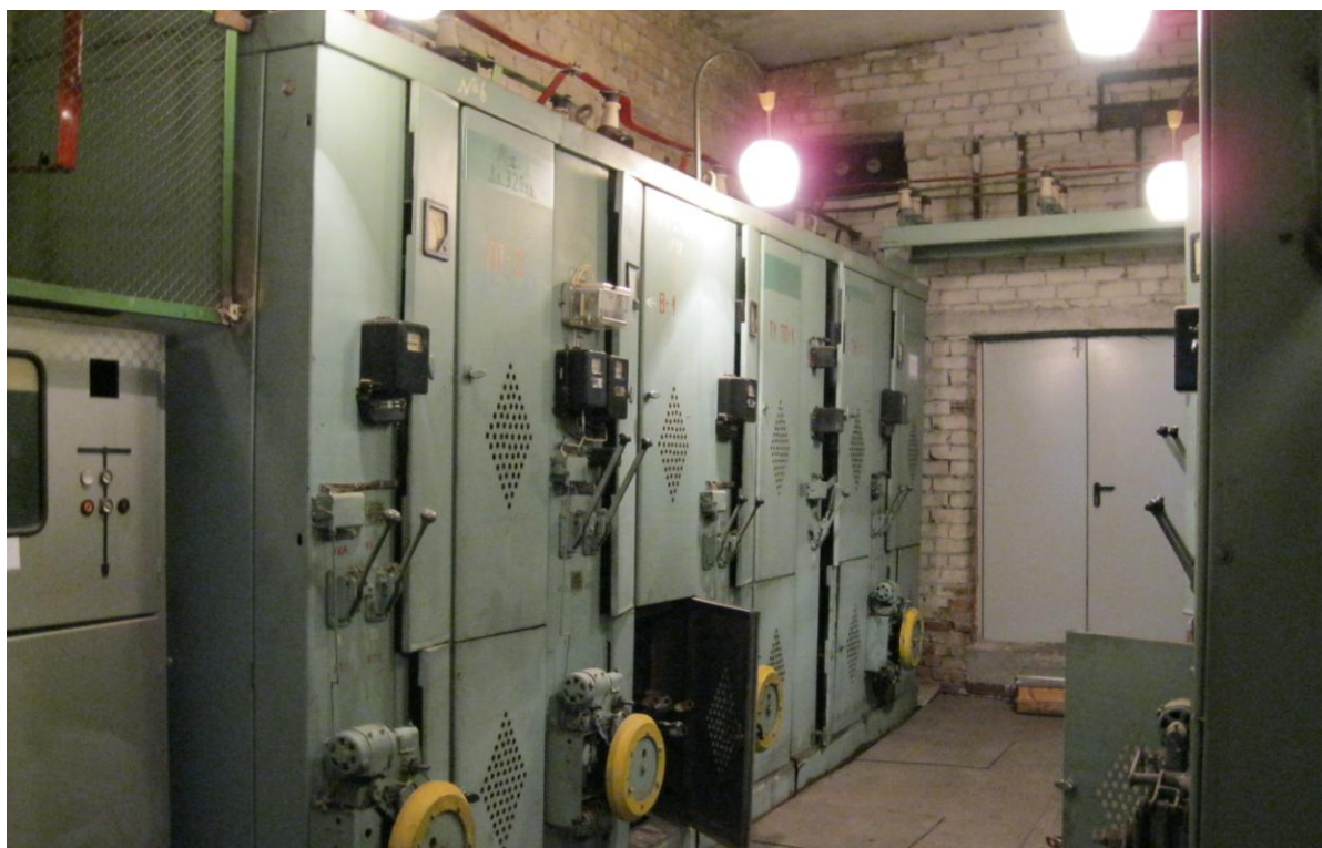
Рисунок 2 – ЗРУ-10 кВ п/ст 110/10
