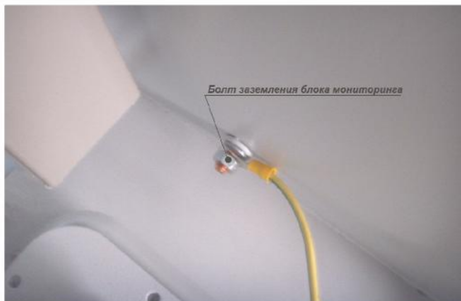
Рисунок 4.1 – Место заземления СНК
