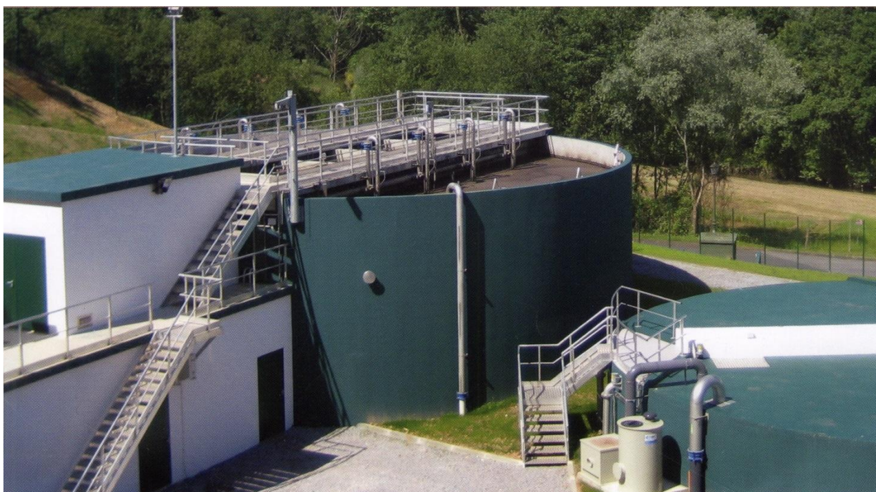
Рисунок 6 – Водоочистная станция с мембранным биореактором в Бассюссари, Франция
