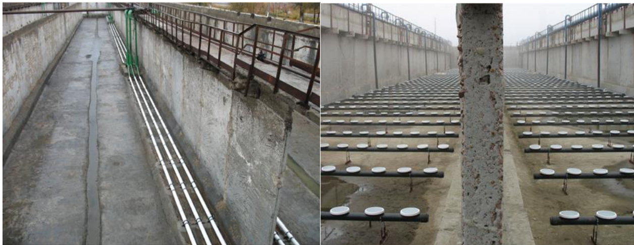
Рисунок 9 - Аэрационные системы аэротенка:
