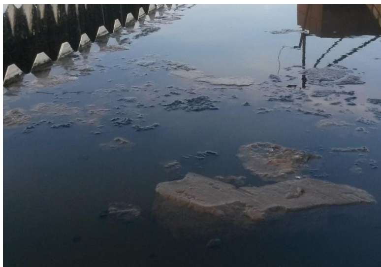
Рисунок 12 – Фото вторичного отстойника со всплывшим илом на поверхности
