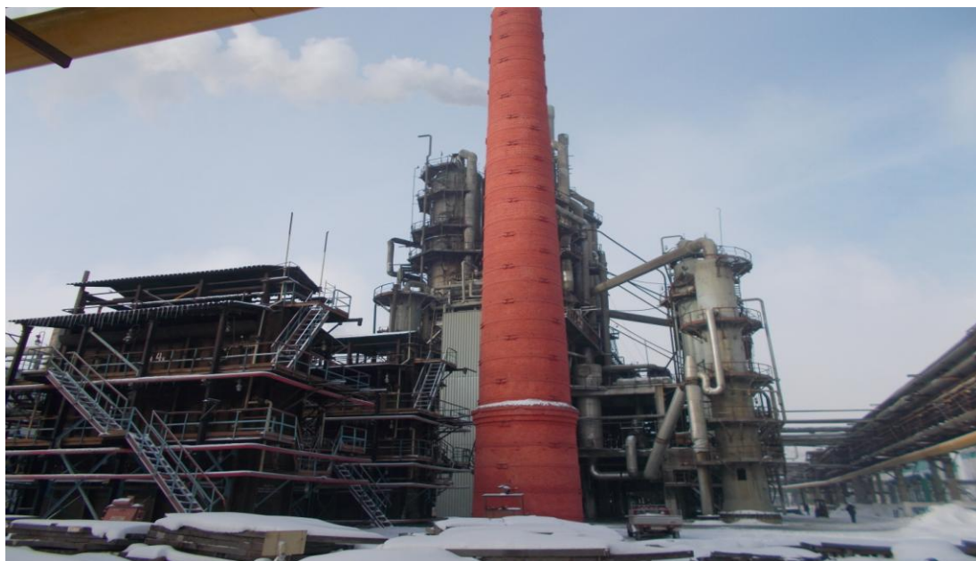
Рисунок 2 – Фото объекта с южной стороны
