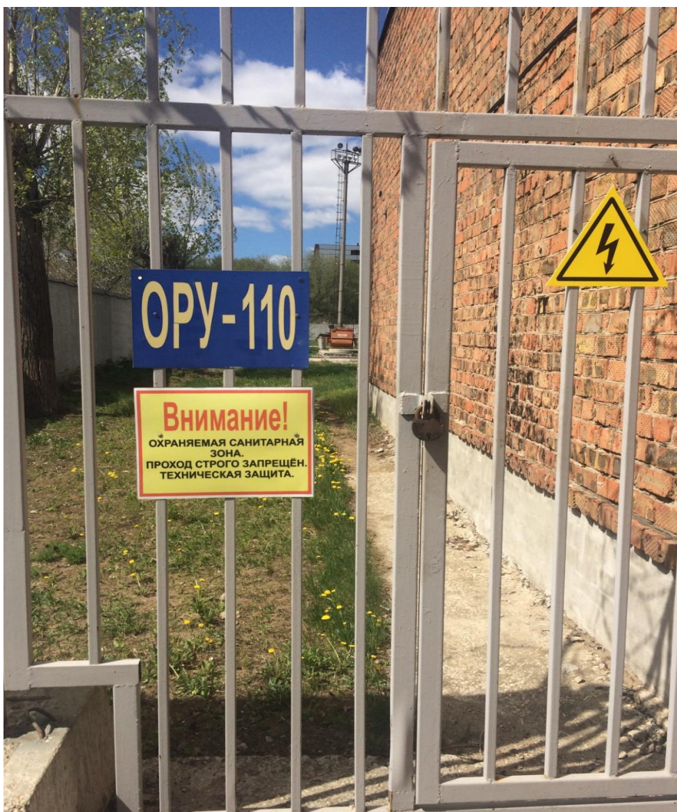
Рисунок Б.1 – Фотография коллективных средств защиты в ОРУ-110 кВ
