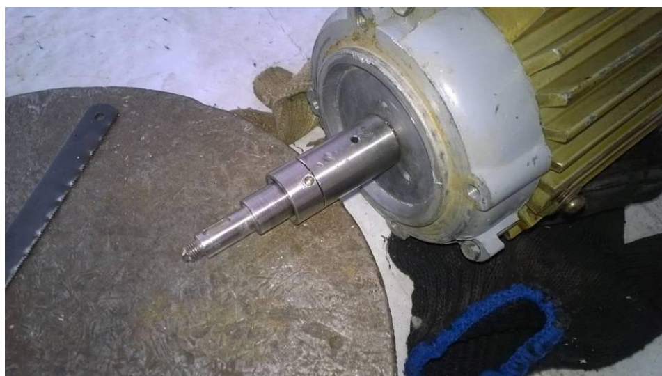
Рисунок 2.5 – Высверленный шплинт промежуточного вала электродвигателя насоса системы охлаждения установки Квант-15
