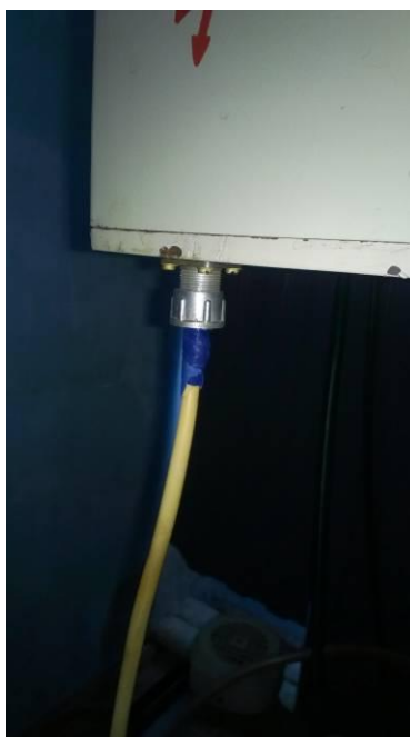
Рисунок 2.24 – Восстановленное соединение Ш5 оптико-механического блока
