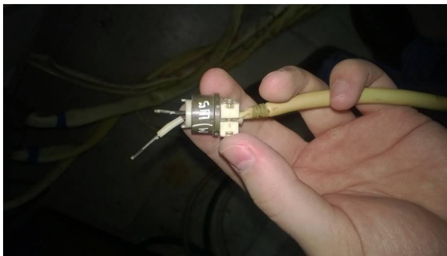
Рисунок 2.23 – Неисправный разъем Ш5 оптико-механического блока.
