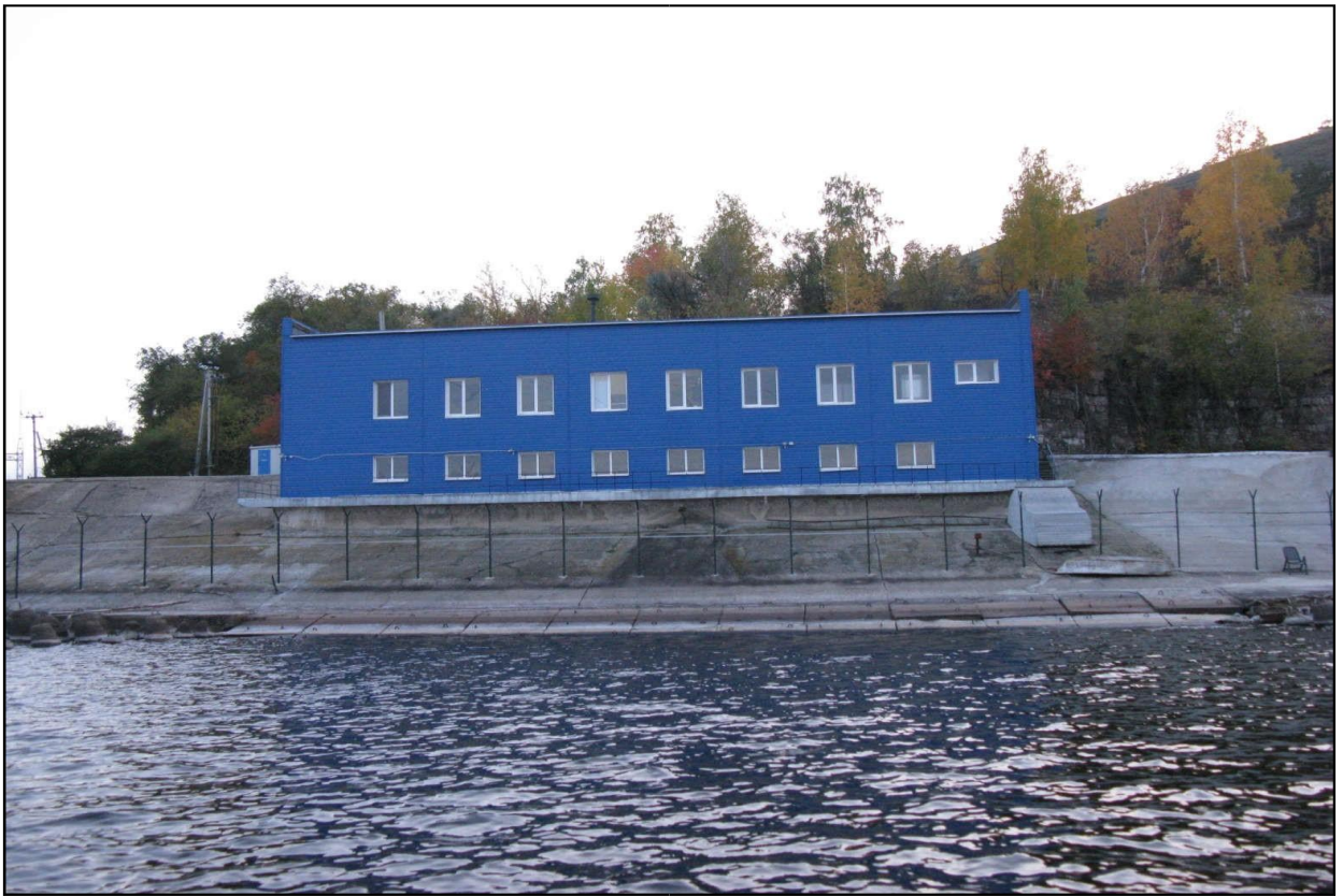
Рисунок 2.14 – Здание береговой насосной станции Жигулёвского водозабора
