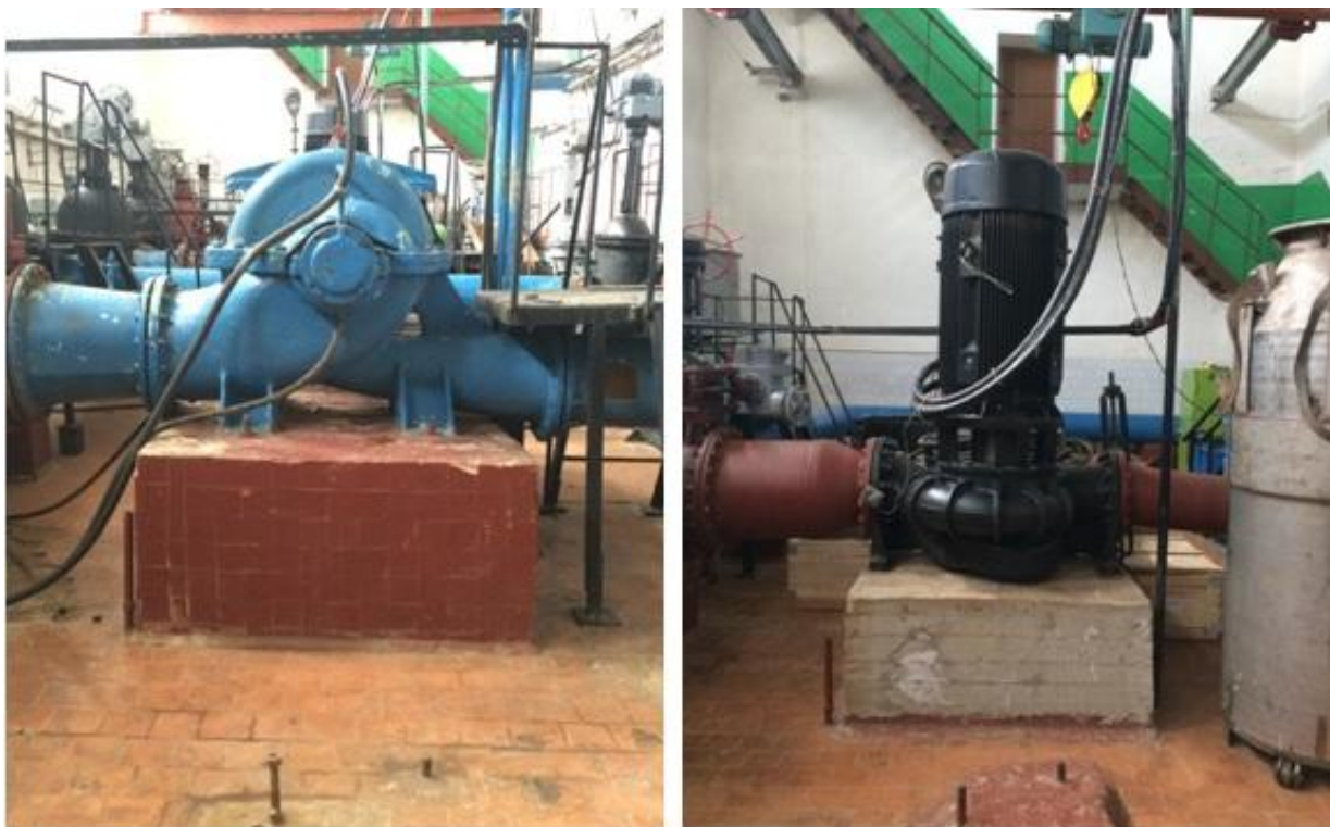
Рисунок 2.5 – Насосные агрегаты до (слева) и после реконструкции (справа)
