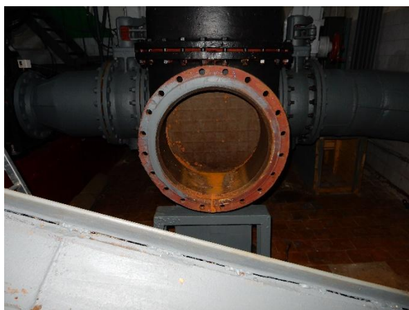
Рисунок 2.12 – Демонтированные соединительные части
