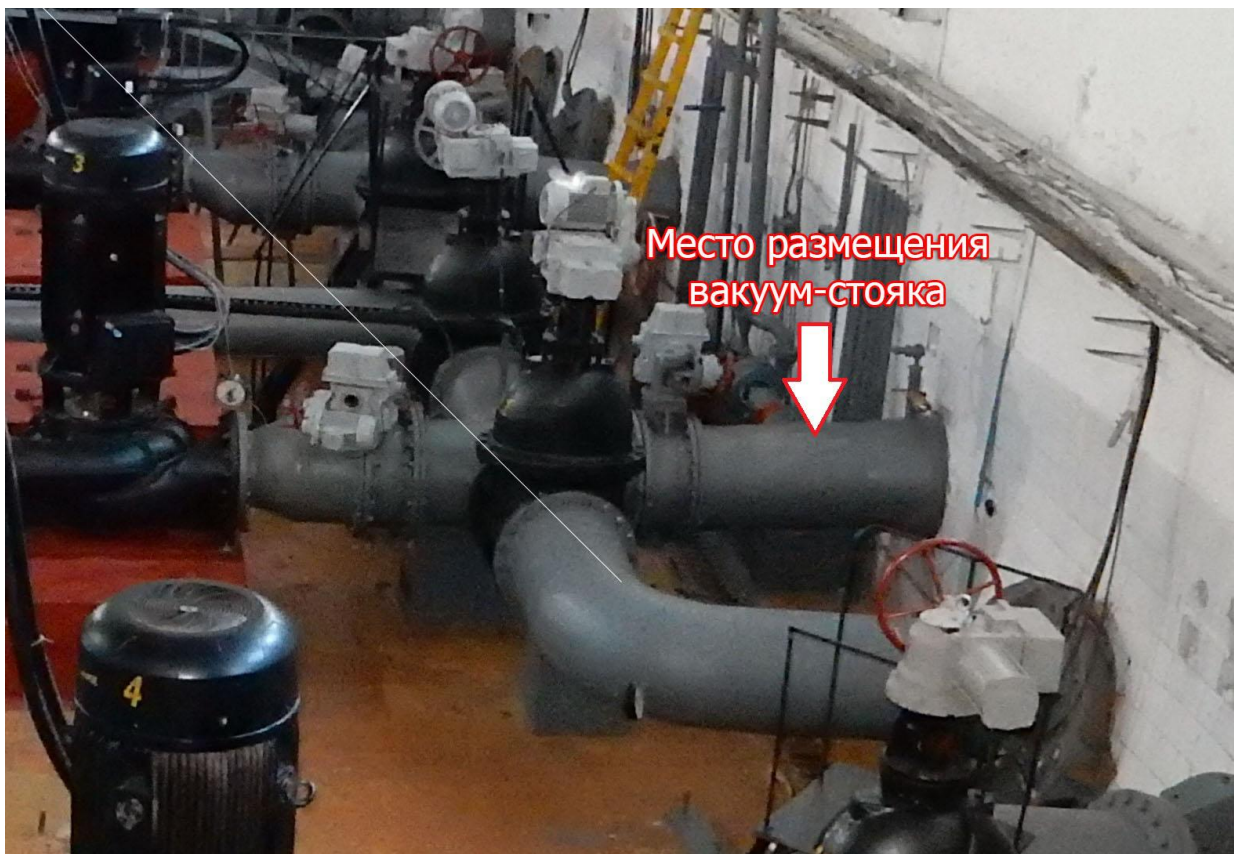
Рисунок 3.6 – Место размещения вакуум-стояка
