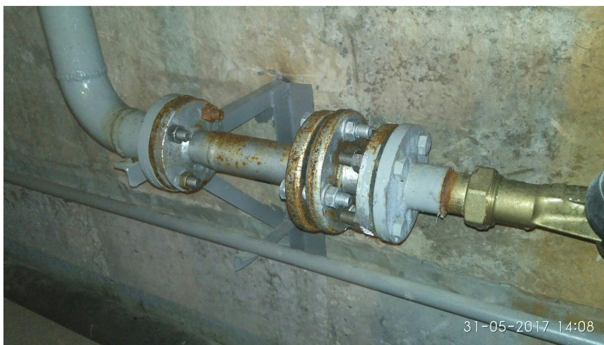
Рисунок 2.18 – Прибор ГМС-40 (гидромагнитная система) Объекта 3
