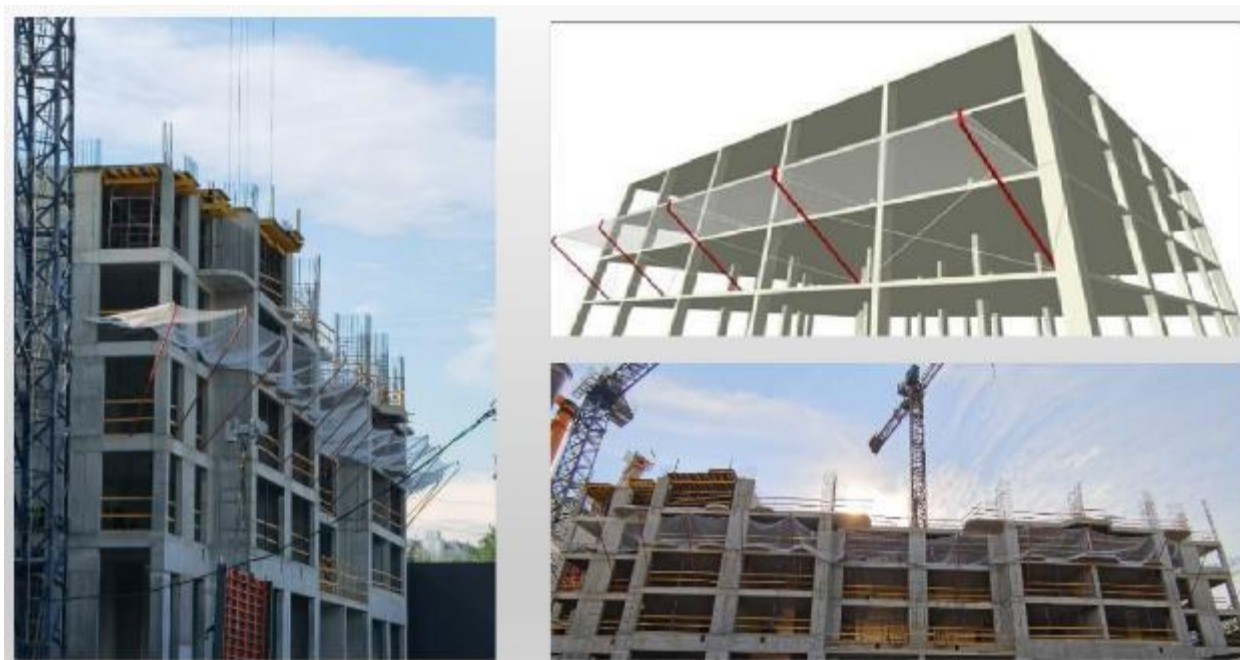
Рисунок 10 – Конструкция защитно-улавливающих сеток
