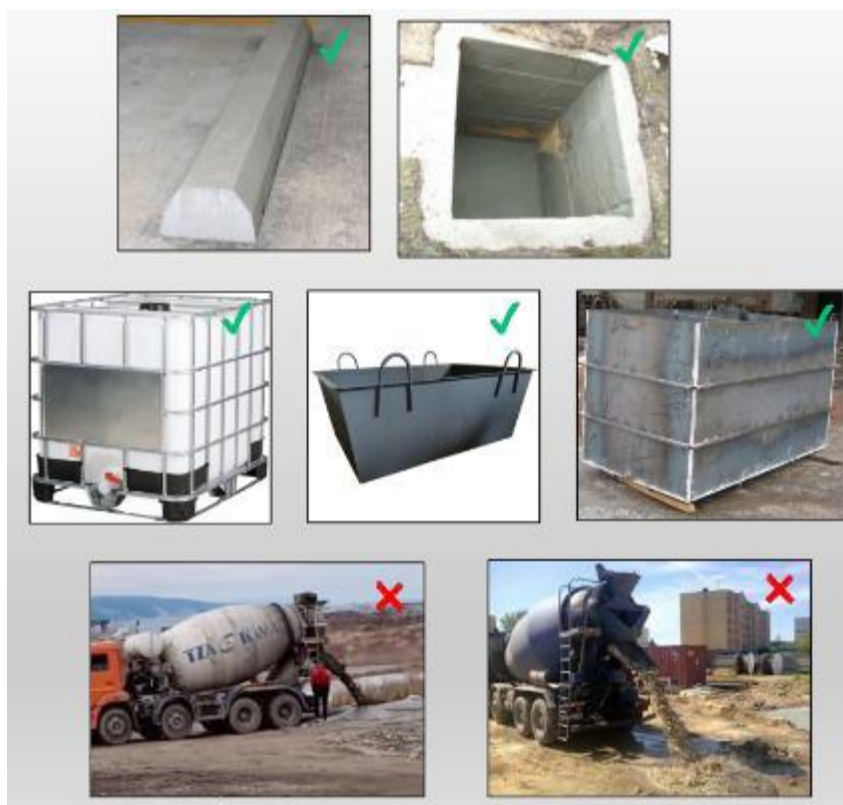
Рисунок 20 – Пример емкости для отработанной массы от промывки лотков
