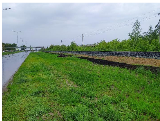
Рисунок Б.4 – Насыпь железной дороги Северная сторона дороги
