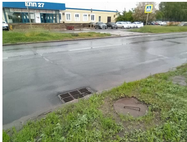
Рисунок Б.2 – Дождеприёмник и КК №114 у КПП 27 Северная сторона дороги
