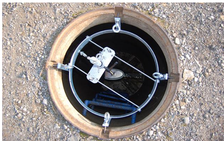
Рисунок 38 – Временная установка контрольного расходомера на открытых колодцах
