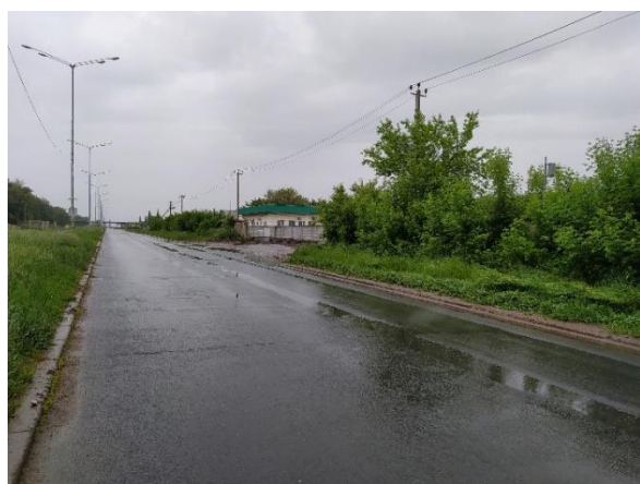
Рисунок Б.9 – Вид от КК №140 в западном направлении Северная сторона дороги
