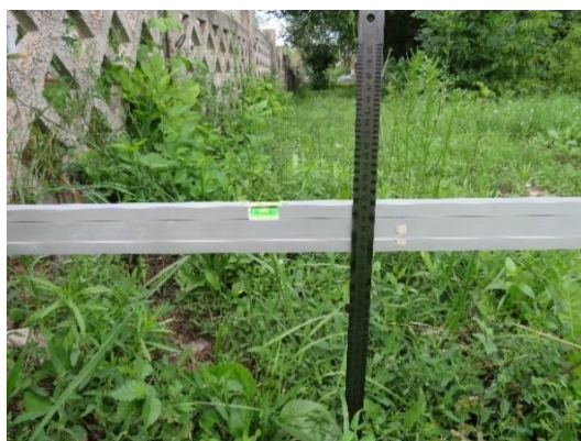
Рисунок 25 – Замер уровня грунта относительно ограждения
