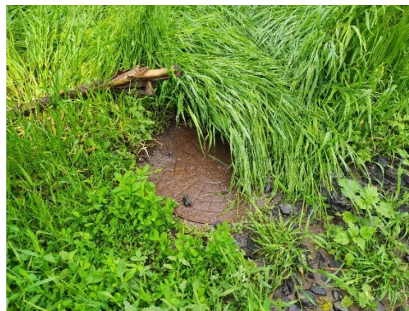
Рисунок Б.8 – Дождеприёмник и КК №140 Северная сторона дороги
