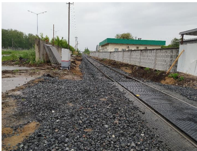
Рисунок Б.11 – Железная дорога в районе КК №140 Западное направление
