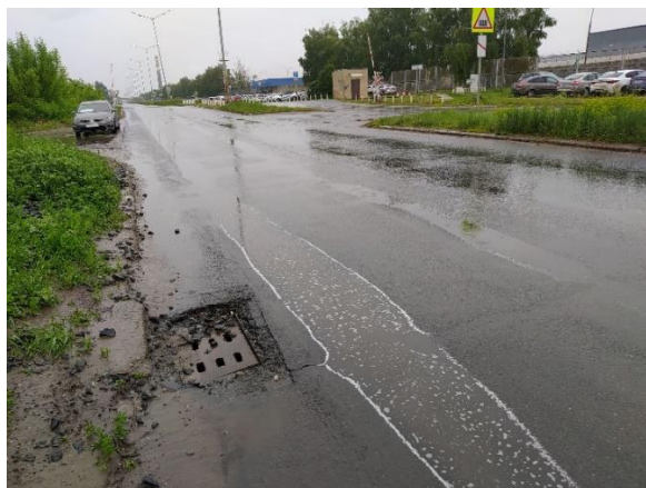
Рисунок Б.7 – Дождеприёмник у КПП 9 Северная сторона дороги
