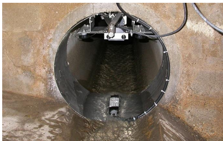
Рисунок 39 – Установка расходомера на горизонтальном участке самотёчного трубопровода
