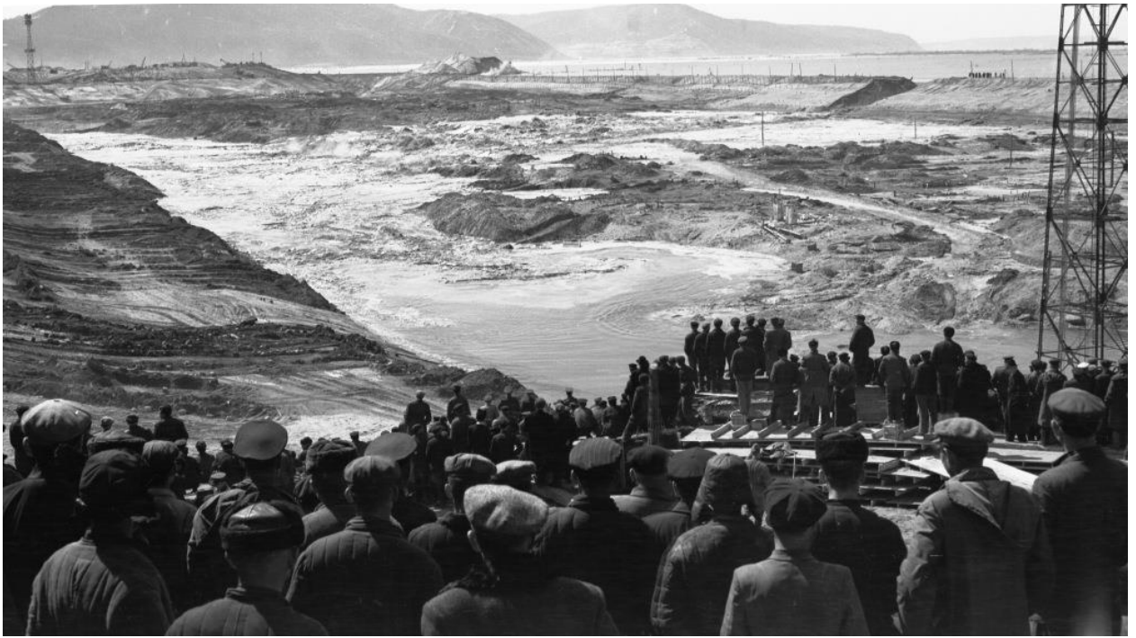
Рисунок 4 – Затопление при строительстве Куйбышевской ГЭС
