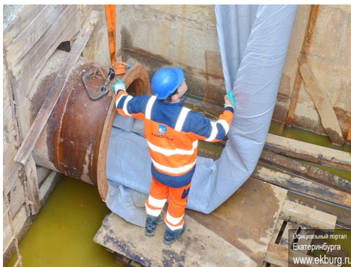
Рисунок 14 – Схема нанесения внутреннего покрытия из гибких пластичных материалов
