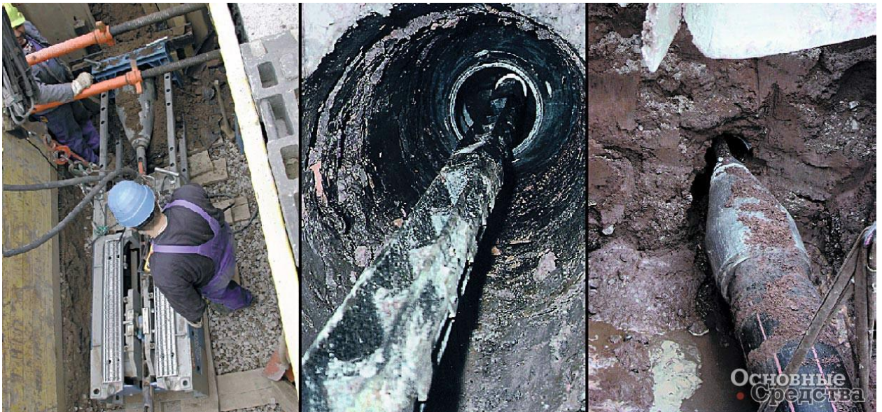
Рисунок 40 – Установка Grundoburst в работе
