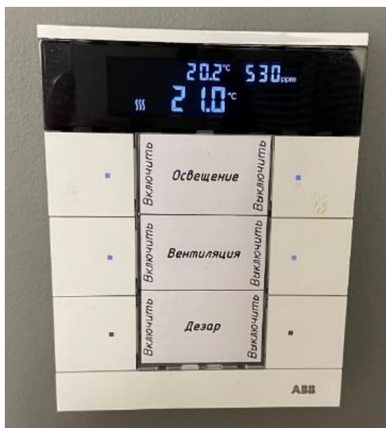
Рисунок 24 – Сенсор с ЖК дисплеем и встроенными датчиками фирмы АВВ
