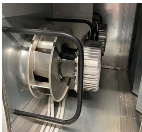
Рисунок 22 – Приточно-вытяжная установка с применением ЕС – вентилятора
