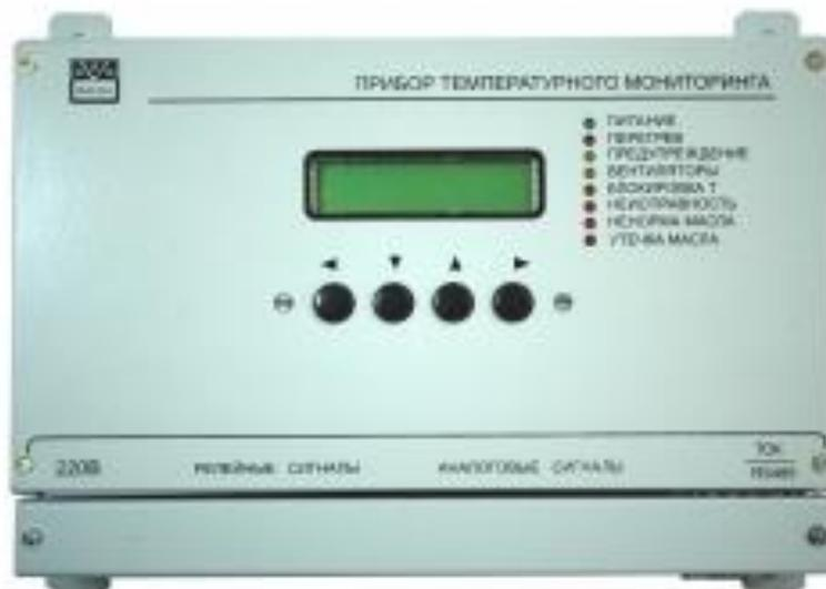
Рисунок 6– Система мониторинга силового трансформатора от компании «Мирономика»
