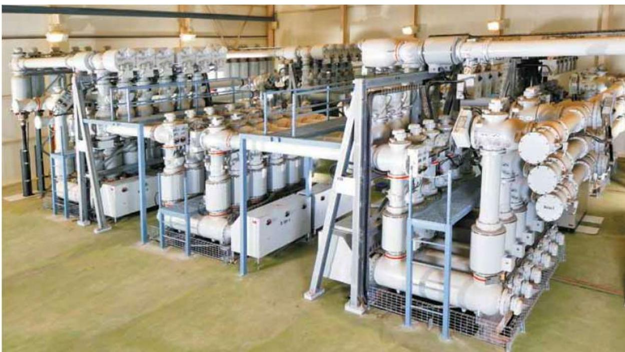
Рисунок 5 – Внешний вид КРУЭ 220 кВ марки АBB ELK-14
