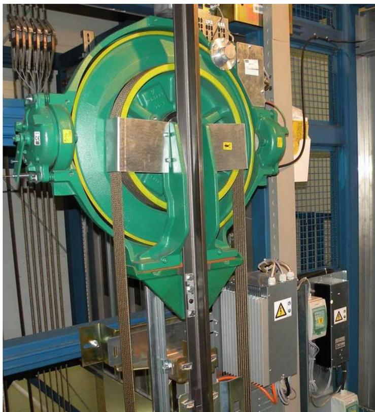
Рисунок 5 – Лифтовой безредукторный электропривод KONE EcoDisc [16]
