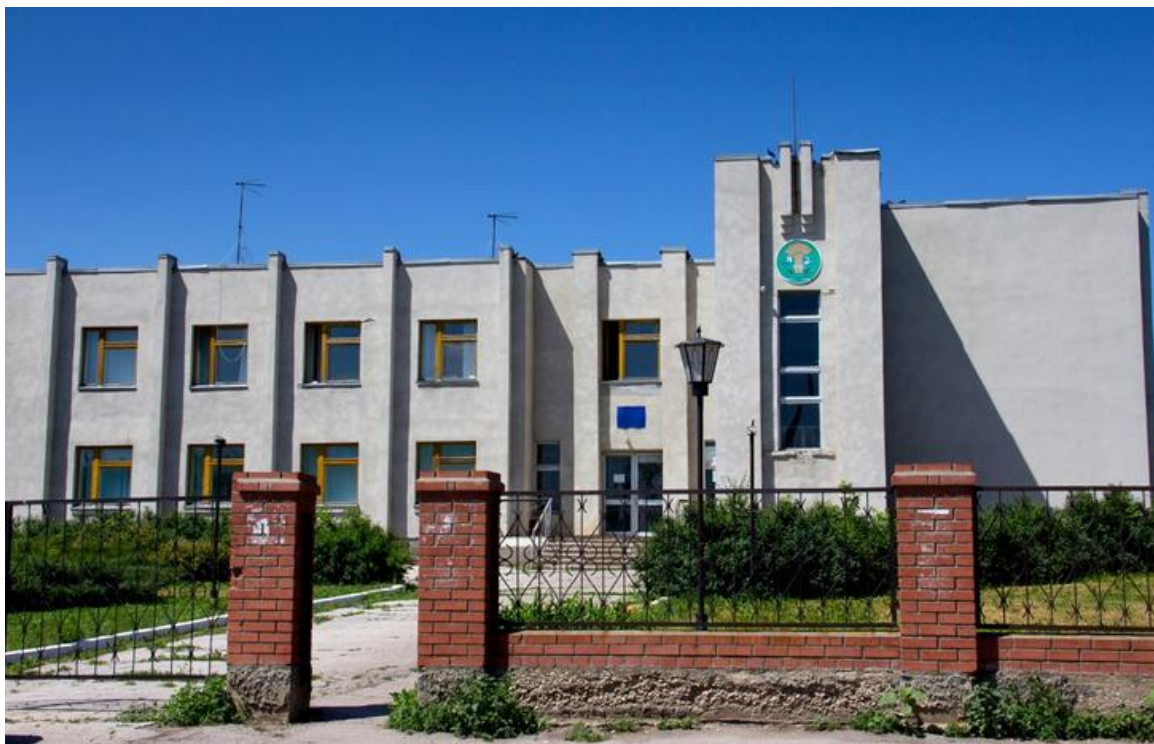
Рисунок 2 – Внешний вид здания ООО «Прогресс», село Дубовый Умет
