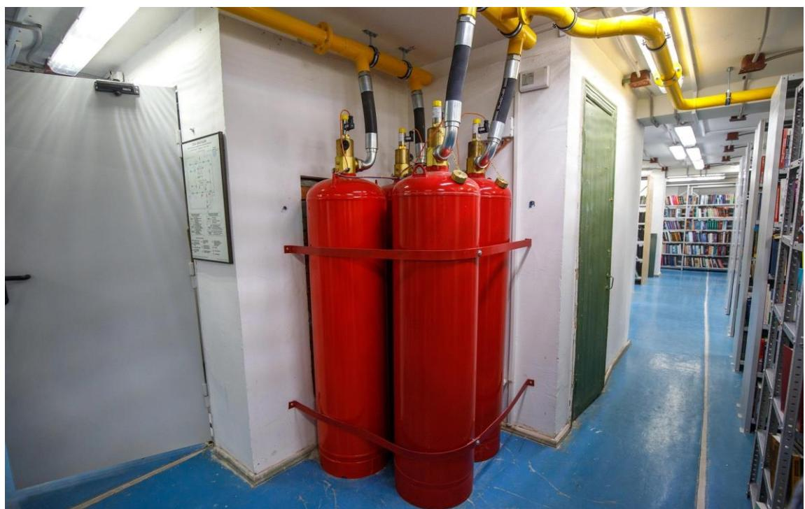
Рисунок 2.6 – САГПТ. Модуль в сборе.
