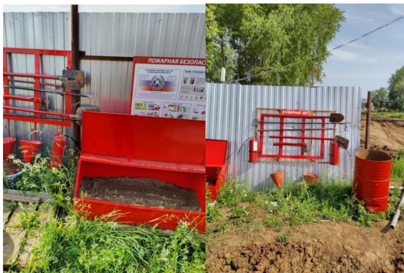
Рисунок 8 – Пожарные щиты на строительной площадке
