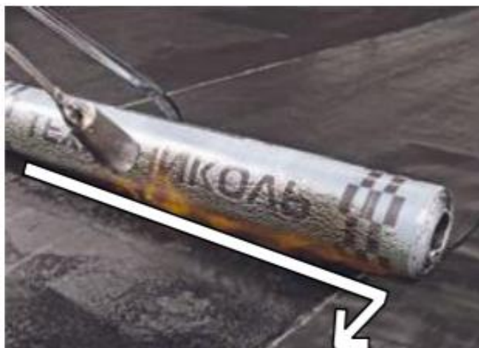
Рисунок 12 – Движение горелки при наплавлении смежных рулонов
