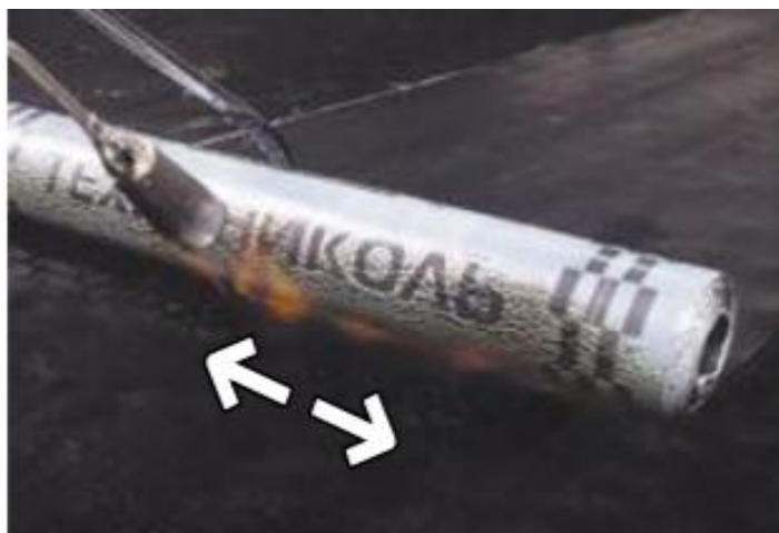
Рисунок 11 – Разогрев рулона
