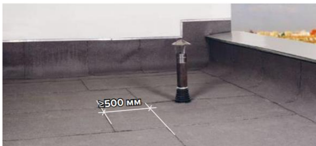
Рисунок 14 – Общий вид кровли после наплавления верхнего слоя
