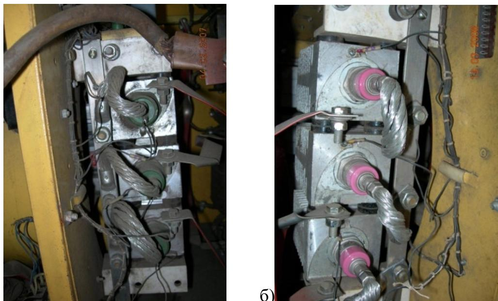
Рисунок 14 – Состав выпрямительного блока в базовом варианте – тиристоры Т161 (а) и в проектном варианте – диоды Д160 (б)
