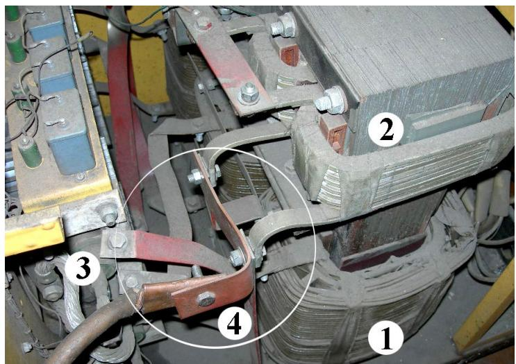
1- силовой трансформатор, 2 – уравнительный реактор, 3 – блок силовых тиристоров, 4 – место подключения силового кабеля
