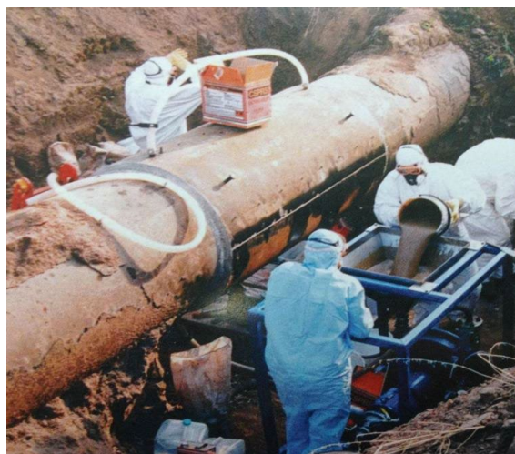
Рисунок 10 – Применение ремонтной муфты П1 для исправления дефекта на магистральном трубопроводе
