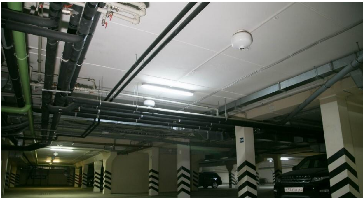
Рисунок 3 – Пожаротушение подземной парковки тонкораспыленной водой
