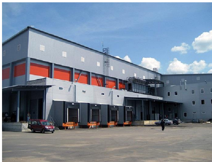
Рисунок 1 – Внешний вид торца здания ООО «НефтеГазКомплект-Импекс»
