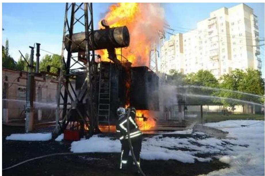
Рисунок 2 – Загорание трансформатора
