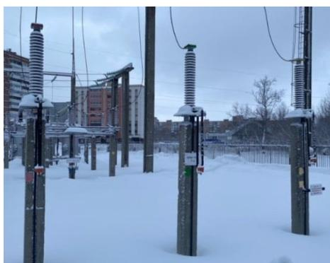
Рисунок 11 – Ограничитель перенапряжений ОПН-П ЗЭУ
