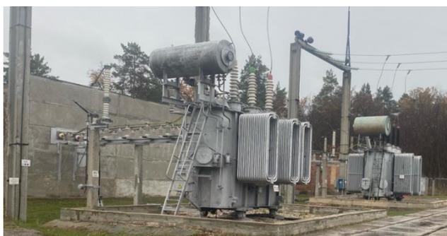
Рисунок 4 – Силовые трансформаторы Т1 и Т2
