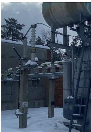
Рисунок 10 – Заземлитель ЗОН-110-М
