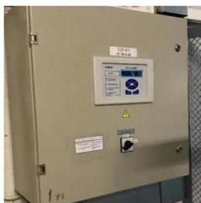
Рисунок 16 – Устройство защиты от дуги
