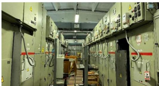
Рисунок 13 – Закрытое распределительное устройство, вид внутри
