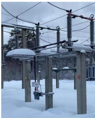
Рисунок 9 – Разъединитель РНДЗ-2-110/630
