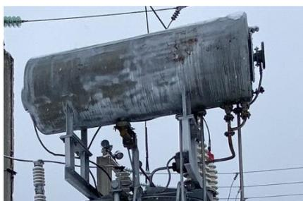
Рисунок 6 – Расширительный бак
