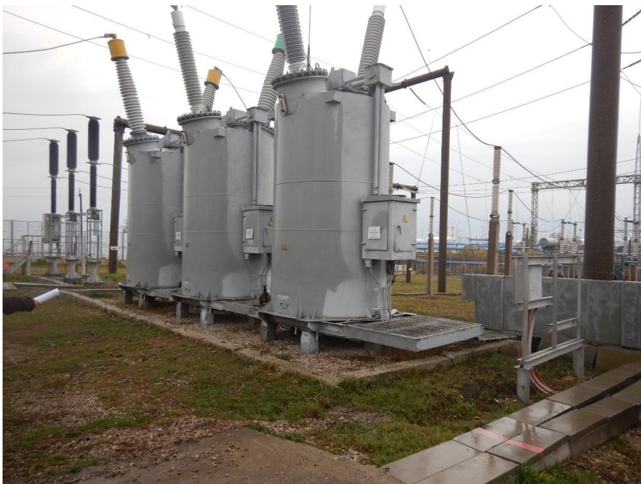
Рисунок 1 – Заменяемый выключатель В 220 Кинельская
