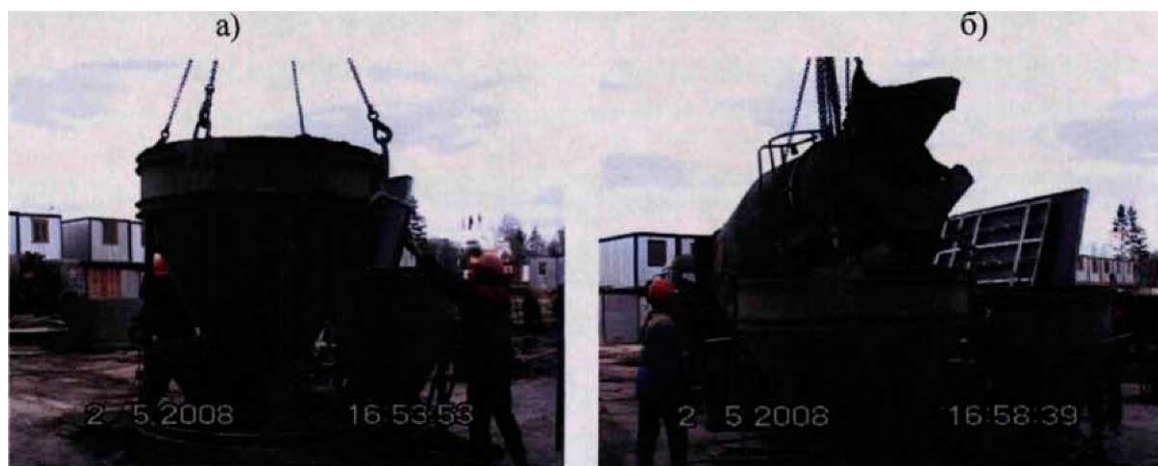
Рисунок 12 – Бетонирование по схеме «кран-бадья»
