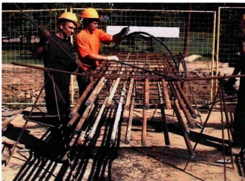
Рисунок 9 – Вязка арматурных каркасов пилонов на козлах.
