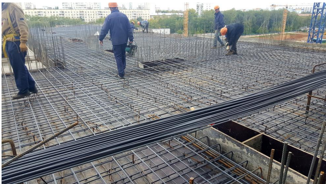
Рисунок 11 – Армирование горизонтальных конструкций
