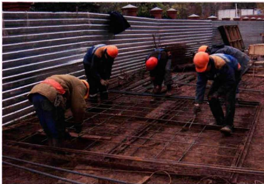
Рисунок 8 – Процесс вязки арматурных каркасов стен на шаблоне.
